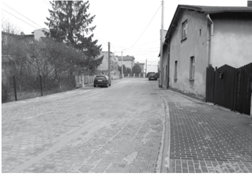
Ulica Kowalska po remoncie
